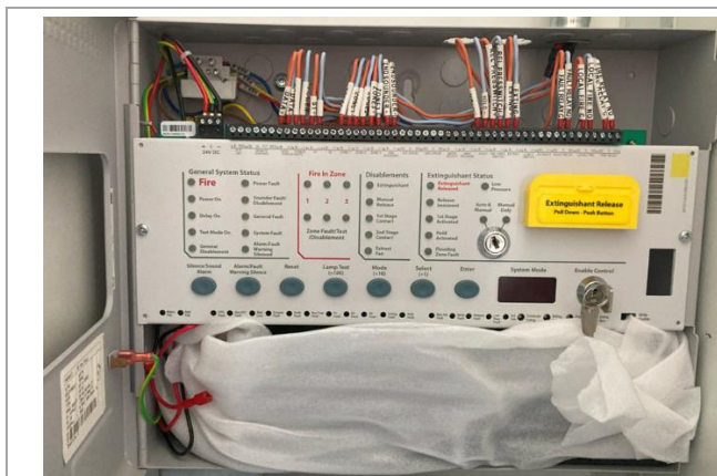
Figure 4-11 : Déballage des batteries au plomb
