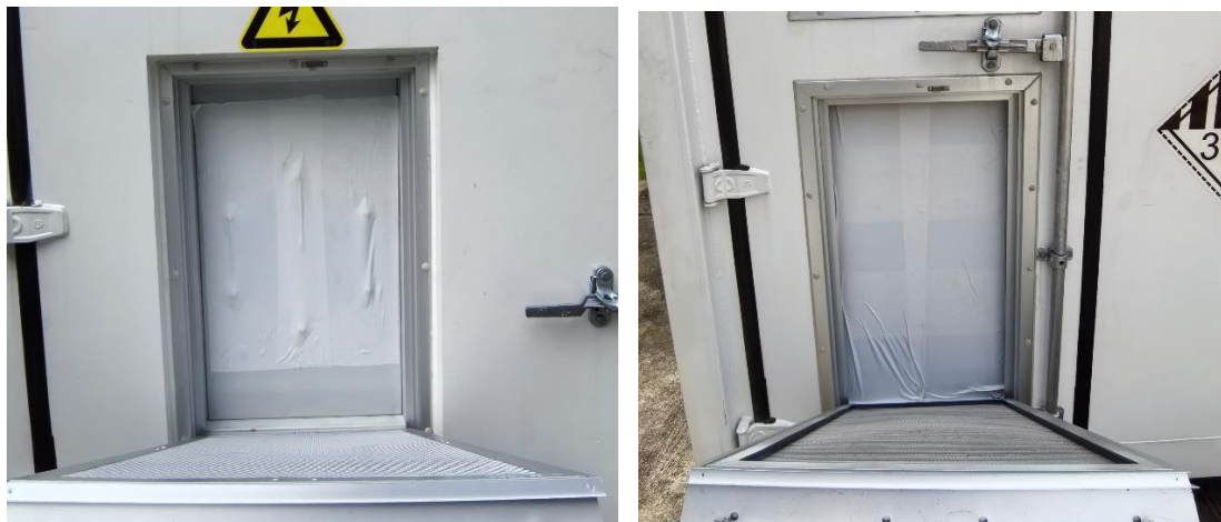
Figura 3-1: Rimozione delle coperture di trasporto di BSC MAX / PWR
